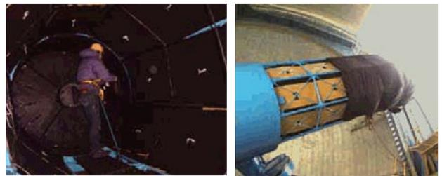
写真左 鏡筒内での黒色板取付作業。写真右 作業後の鏡筒外観。
