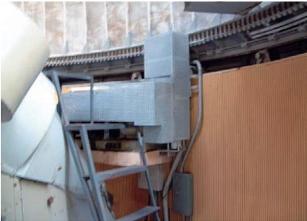
図 2-76 ドーム回転ギア、モーター部
